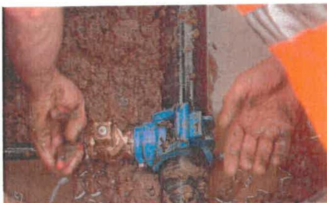
**FUITE du RESEAU D'EAU de MOUNENS :** Après plus d'un mois de recherches vaines, la fuite sur le réseau d'eau a pu être repérée dans un premier temps pour être réparée avec l'aide de l'entreprise de David Antérior et des employés municipaux. Une racine d'arbre était la cause du dommage sur la conduite PVC du réseau installé dans les années 70. A l'occasion de cette réparation, il a été judicieux d'installer deux vannes d'isolement du circuit.
