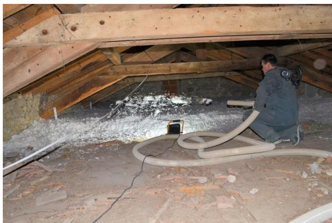
**Economie d'énergie :** L'isolation des combles de la mairie, bureaux et salle des fêtes, a été réalisée par l'entreprise C2E Concept représentée par M. Leyral. La projection de flocons de cellulose sur une épaisseur de 32 cm va permettre une économie de chauffage substantielle, et ce pour une facture de 60 euros. L'opération sera étendue aux logements sociaux municipaux qui sont éligibles à ce mode d'isolation.
