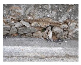
Pont de Lapras: Avant les travaux de sécurisation de la traversée de Lapras, le parapet a été consolidé. Le ciment de jointement des pierres, altéré par le sel s'était complètement détérioré. Cette remise en état par les employés communaux était nécessaire avant la pose de la chicane.
